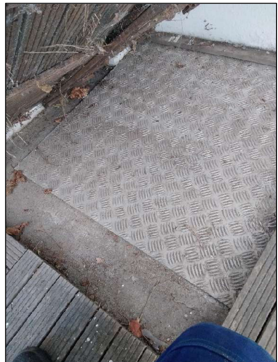
Plaque pompe de relevage non étanche
