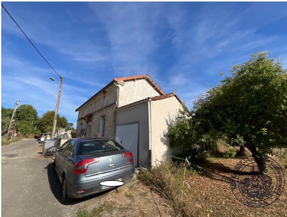
Les murs pignon sont en crépi. Les tuiles de rive côté gauche sont en mauvais état.
