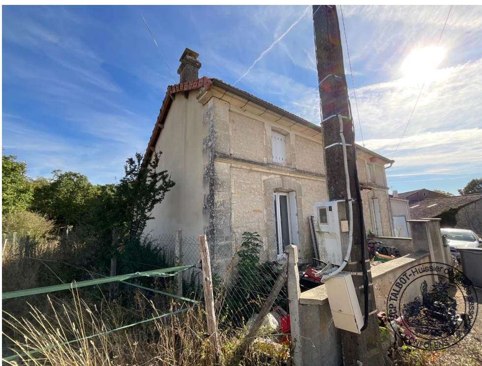
Les murs pignon sont en crépi. Les tuiles de rive côté gauche sont en mauvais état.
