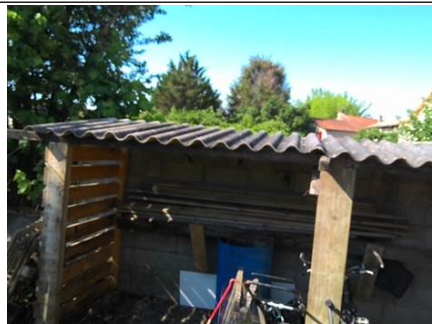
Photo n° PhA003 Localisation : Rez de chaussée - Appentis 3 Ouvrage : 1. Toiture et étanchéité - Plaques ondulées Partie d'ouvrage : Plaques en fibres-ciment Description : Plaques en fibres-ciment Localisation sur croquis : M003
