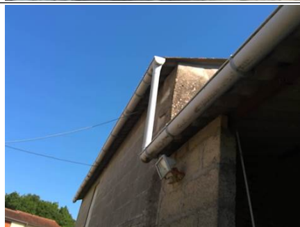
Photo n° PhA002 Localisation : Rez de chaussée - annexe 1 Ouvrage : 1. Toiture et étanchéité - Plaques ondulées Partie d'ouvrage : Plaques en fibres-ciment Description : Plaques en fibres-ciment Localisation sur croquis : M002
