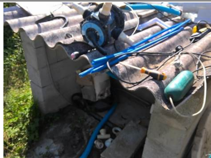
Photo n° PhA005 Localisation : Rez de chaussée - Abri piscine Ouvrage : 1. Toiture et étanchéité - Plaques ondulées Partie d'ouvrage : Plaques en fibres-ciment Description : Plaques en fibres-ciment
